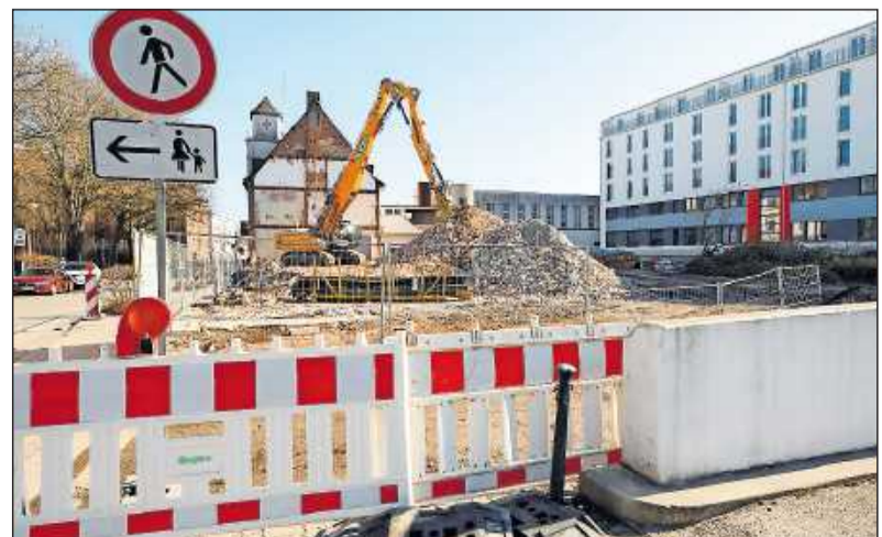
Februar 2021: Der Turm und das Eckhaus stehen noch. FOTO: VIEW
