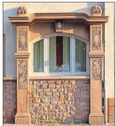
Detail aus der Sockel-Ebene des DRK-Gebäudes. FOTO: CLEMENS/GTA-KL-DE
